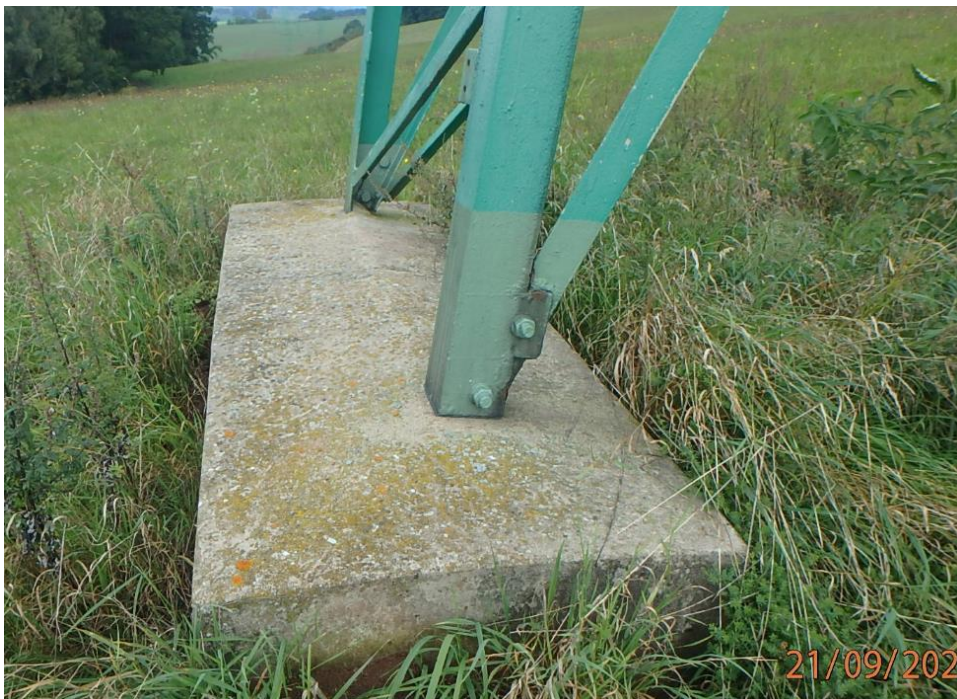
Obr. 11 Základy podpěrného bodu, č.30 (zdroj ČEPS eSADA)
