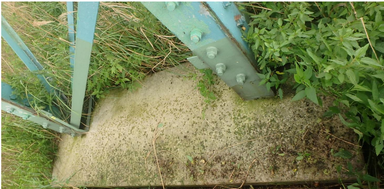
Obr. 6 Základy podpěrného bodu, č.11 (zdroj ČEPS eSADA)
