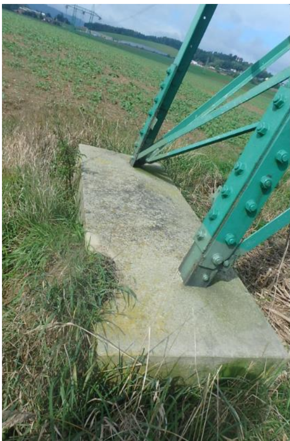
Obr. 10 Základy podpěrného bodu, č.22 (zdroj ČEPS eSADA)
